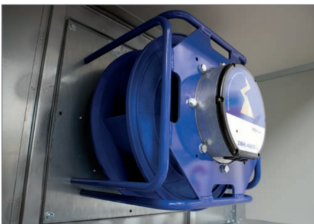
VENTILATORE PLUG FAN A PARETE
