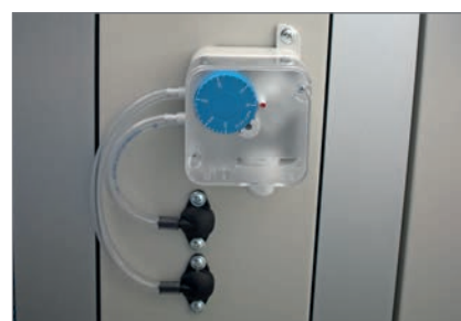
PRESSOSTATO DIFFERENZIALE
